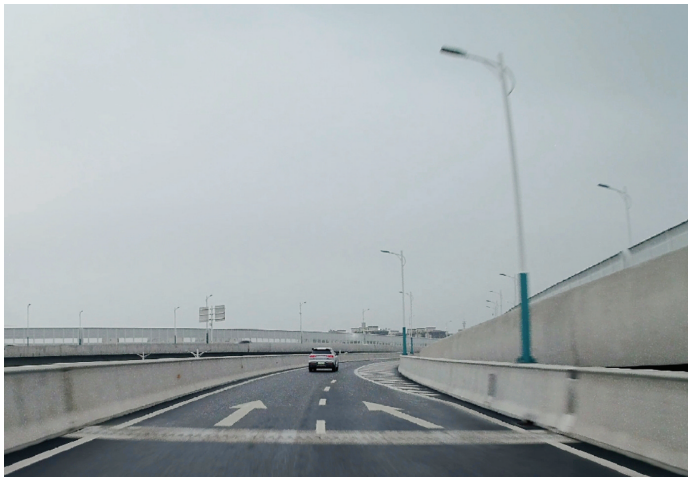
记者现场回访,该路段高架伸缩缝处已进行防滑处理
