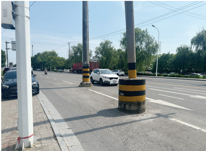
“拦路”电线杆挤占非机动车道的地盘
