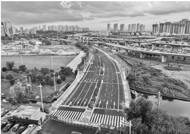
7月22日，南京市建邺区金沙江东街东延工程建设收尾，这条搁置十余年的城市断点道路即将验收通车，道路全长约847米，通车后将完善片区路网结构，有效分流周边车流，方便居民日常出行。
