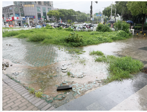
雨天积水严重
