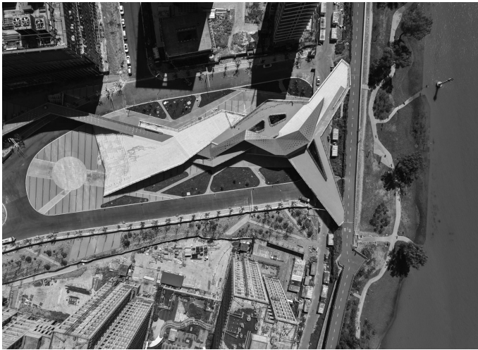
7月29日,航拍进入工程收尾阶段的南京上元门观江平台项目。建筑风貌完整呈现,艺术感十足,滨江岸线新地标来了。该平台全长约213米,最高处达14.5米,临江面宽90.9米。宋宁 摄 视觉江苏网供图
