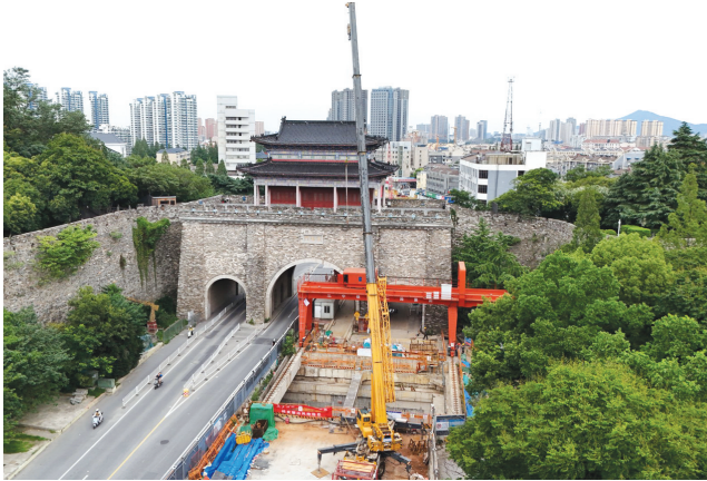
施工现场 吴俊 摄 视觉江苏网供图
