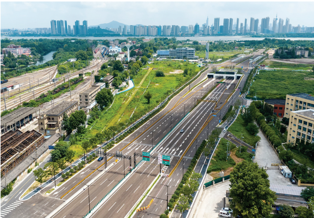
8月20日,南京建宁路长江隧道正式通车 万程鹏 摄 视觉江苏网供图
