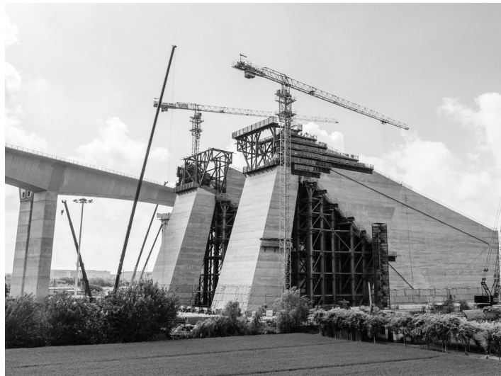
正在施工中的张靖皋长江大桥南航道桥南锚碇
