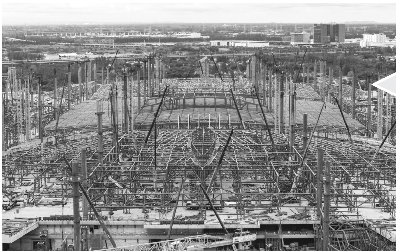
8月30日,空中俯瞰建设中的南京北站,屋面钢结构造型已初见雏形。 南京北站总建筑面积约69.21万平方米,站场规模16台30线,规划引入沪渝蓉沿江高铁、宁淮城际铁路等多条线路,是集高速铁路、城际铁路、普速铁路于一体的综合性铁路客站。 万程鹏 摄 视觉江苏网供图
