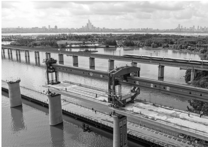
9月1日拍摄的通甬高铁苏虞特大桥跨阳澄湖水域箱梁架设施工现场 新华社记者 李博 摄
