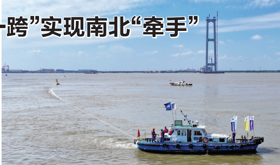
9月10日,一根迪尼玛绳自长江南岸破风而出,经船舶牵引与北岸精准对接。张筠 摄
