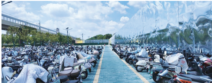
非机动车停车区域,阳光经围挡反射后直射车辆,存在安全隐患
