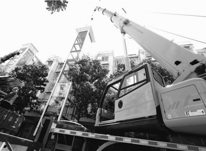
9 月 14 日,工作人员在徐州市鼓楼区永业世纪花园小区进行加装电梯施工。今年以来,徐州市鼓楼区加快推进老旧小区加装电梯进程,改善群众居住环境。 蒯创 翟建 摄 视觉江苏网供图
