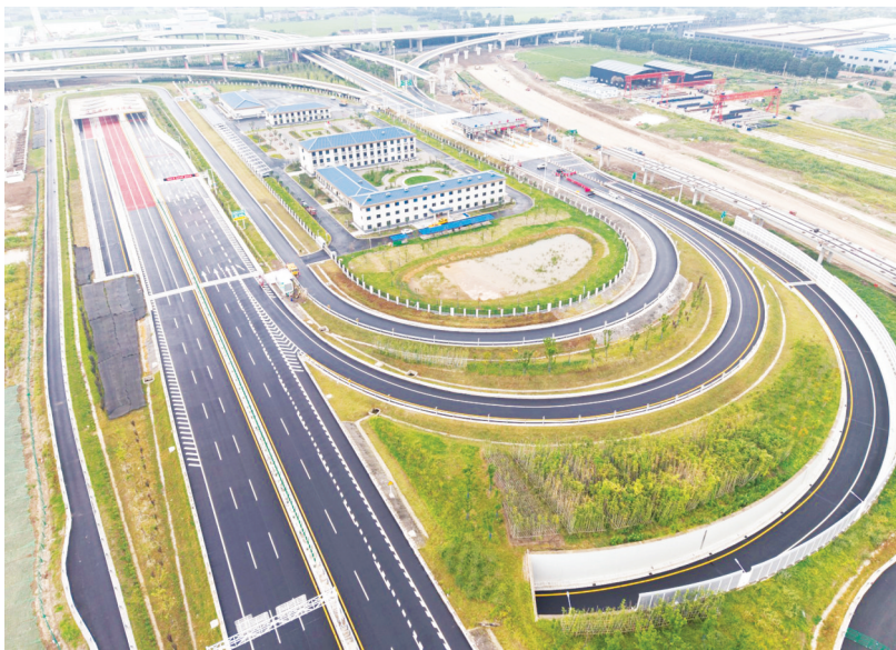
江阴靖江长江隧道北岸靖江入口处建设全貌 戴少丹 摄 视觉江苏网供图
