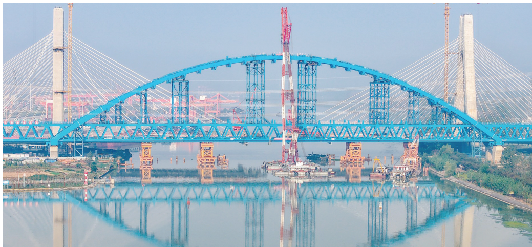
10月12日，淮宿高铁跨京杭大运河特大桥钢桁梁拱桥成功合龙 王帅甫 摄 视觉江苏网供图
